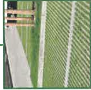
Verickerungsfähige Beläge. z.B. Rasenfugenpflaster und versickerungsfähiger Pflasterbelag
