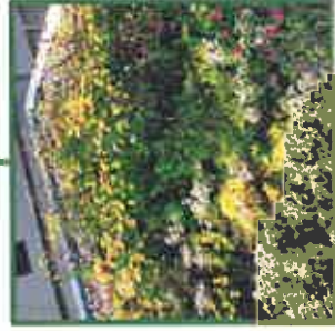
Extensive Dachbegrünung mit Regenrückhaltung
