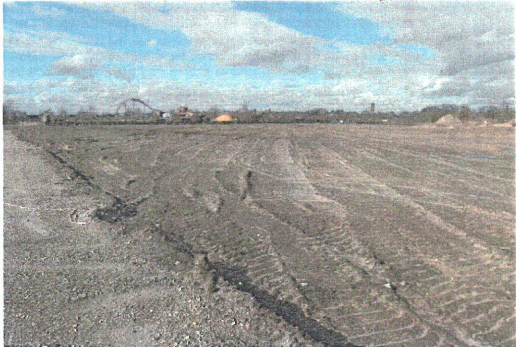
Abbildung 3-1: Übersicht über die für den Interims-Parkplatz vorgesehene Gesamtfläche in ihrem gegenwärtigen Zustand. Fotostandort: Baustellenzufahrt südöstlich des geplanten Interims-Parkplatzes; Blickrichtung Nordwest. Im Hintergrund die Straßenbäume an der Straße „Zur Döberitzer Heide“ und dahinter Karls.
