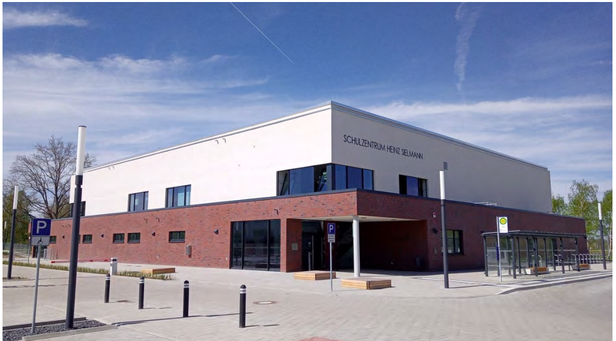
Abb. 12 Blick von der Maulbeerallee auf die Dreifeld-Sporthalle der Heinz-Sielmann-Oberschule © Gemeinde Wustermark 10.05.2021
