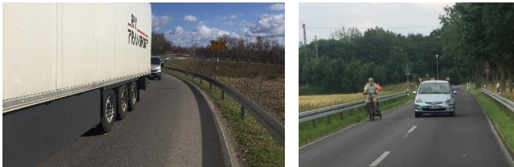
Abbildung 26: Gemischte Führung des Rad- und Kfz-Verkehrs mit zusätzlich gefährdender Leitplanke im Kuhdammweg – Zufahrt GVZ (Bild li.) und auf der Priorter Str. in Ri. Priort (Bild re.)
