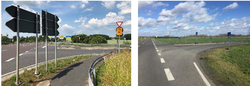
Abbildung 27: Nachrangige und unübersichtliche Führung des Radverkehrs am Knotenpunkt B5/L863/L204 nördlich von Elstal (Bild li.) und am Knoten Zeestower Str. / Kuhdammweg (re.)
