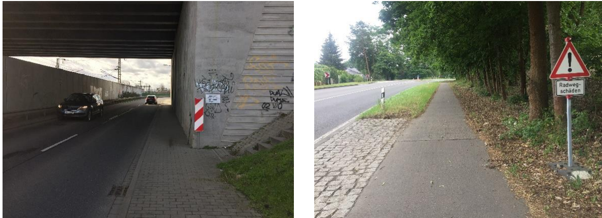
Abbildung 23: Engstelle im GVZ (Bild li.) und Radwegschäden auf der Potsdamer Str. (Bild re.)
