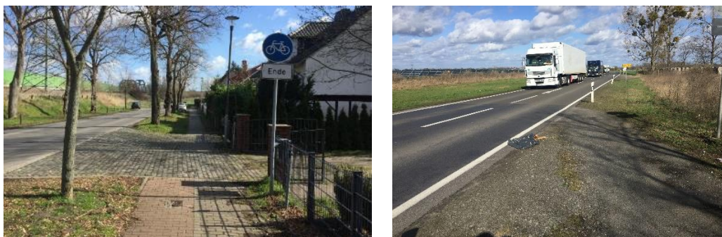
Abbildung 24: Unzureichend dimensionierter und plötzlich endender Radweg in der Zeetower Straße in Wustermark, südlich (Bild li.) und nördlich (Bild re.) der Lehrter Bahn
