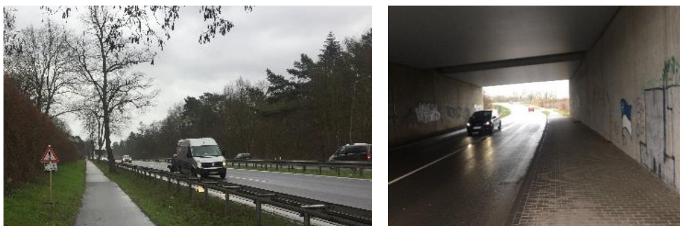
Abbildung 28: B5 in Elstal (Bild li.) und umwegige sowie unattraktive Radverkehrsführung in der Nauener Straße nahe des Designer Outlets Berlin in Elstal (Bild re.).
