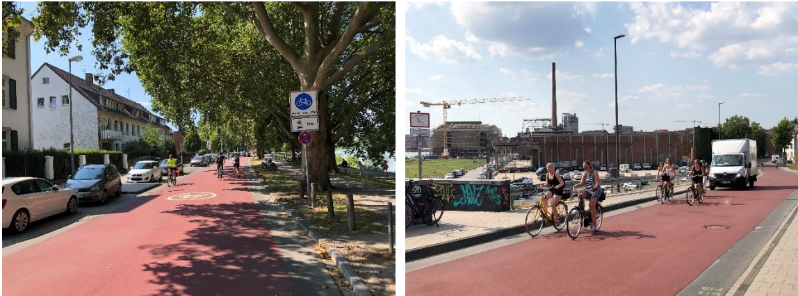
Abbildung 11: Farbliche Einfärbung von Fahrradstraßen in Münster (Bismarckallee und Schillerstraße)
