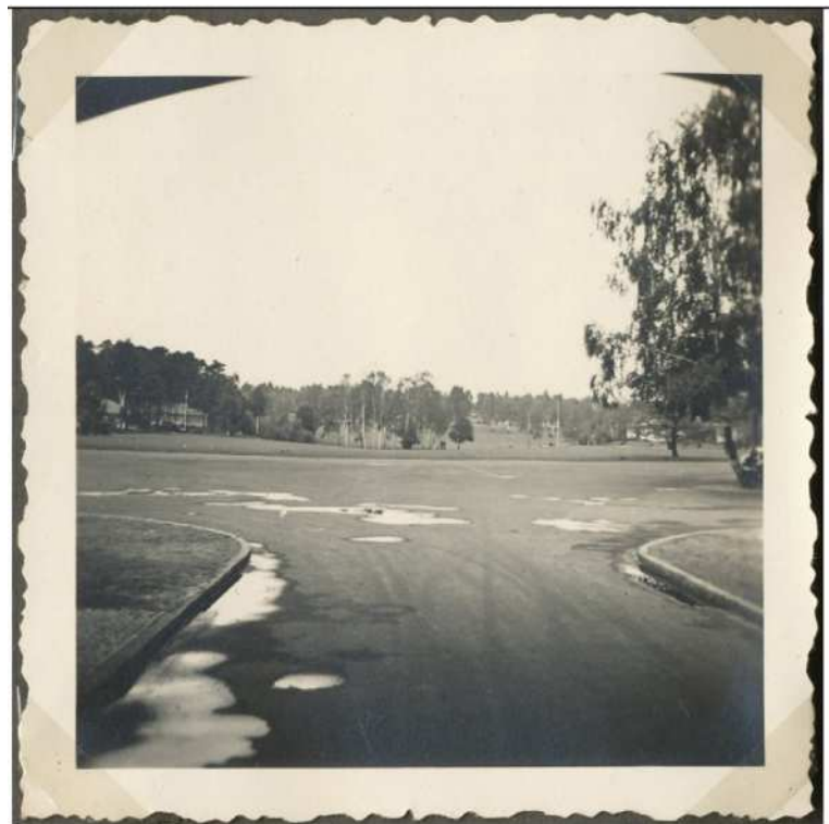
Abb. 23: Blick durch das Tor des Eingangsgebäudes auf den Birkenring
