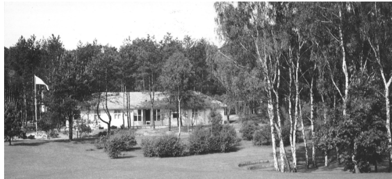
Abb. 28: Ärztehaus, Blick von der unteren Aue auf Birkenring und Bastion, 1936
