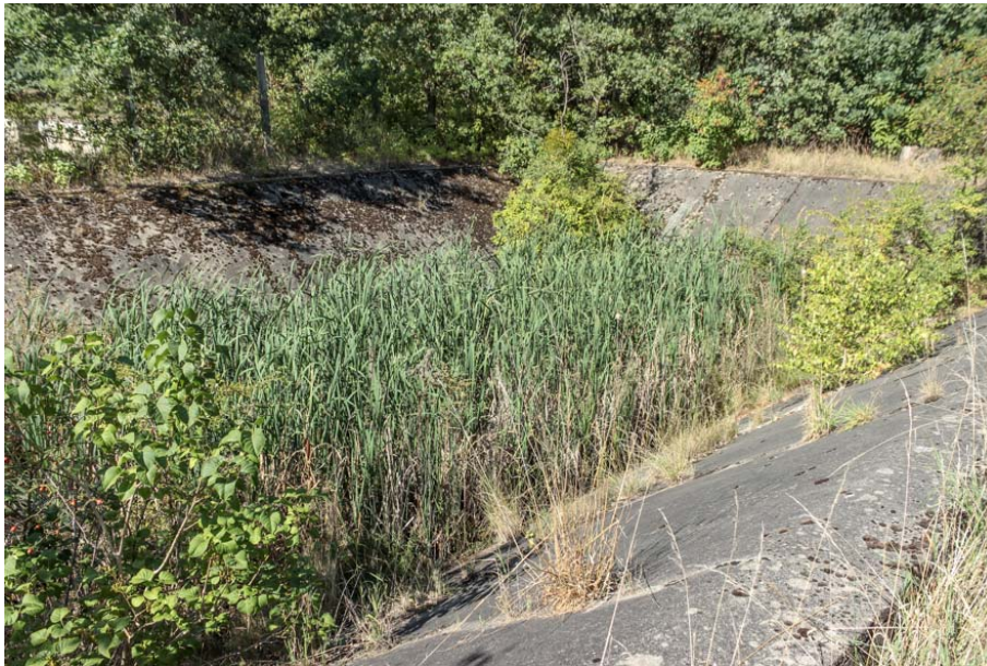
Bild 2: Naturfernes Becken mit dichtem Röhrichtbewuchs
