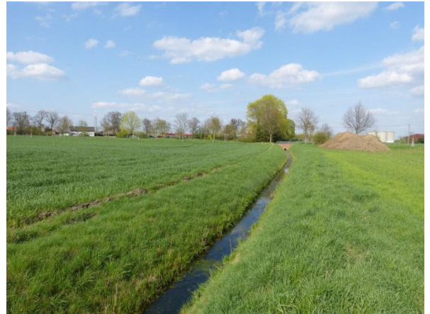
Abb. 21 Blick von der Landesstraße (L) 204 in westliche Richtung entlang des Wismathengraben © Frank Schulze 17.04.2018
