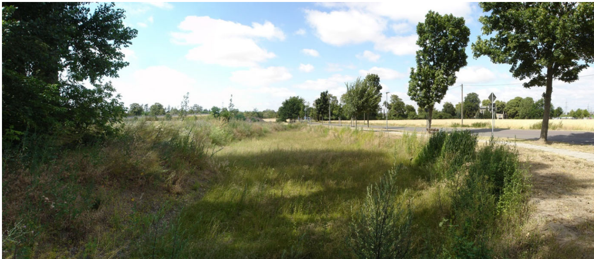
Abb. 22 Blick vom Mühlenweg auf das angelegte Versickerungs- und Verdunstungsbecken an der Neuen Bahnhofstraße © Steffen Pfrogner 10.07.2019
