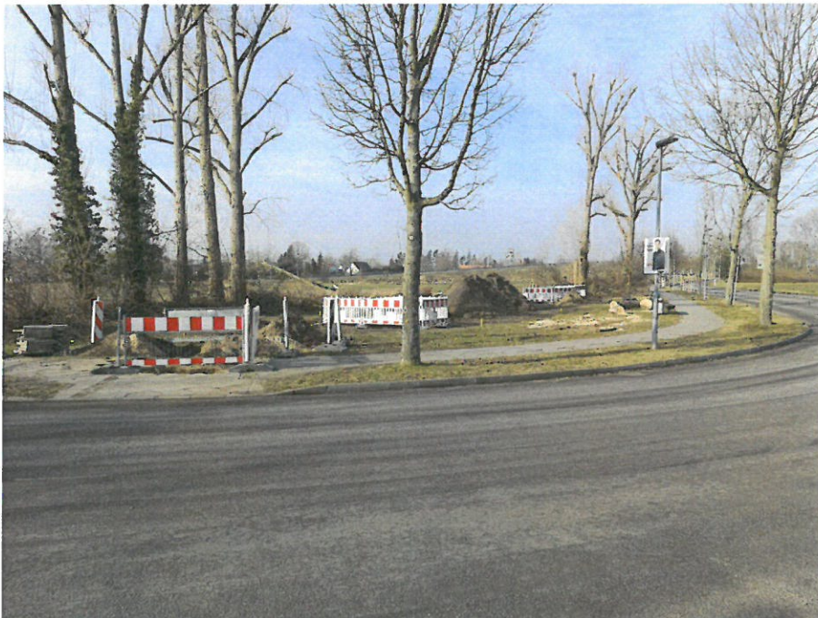
Abb. 1: Ansicht Beprobungsfläche, Neue Bahnhofstr./Ecke Mühlenweg
