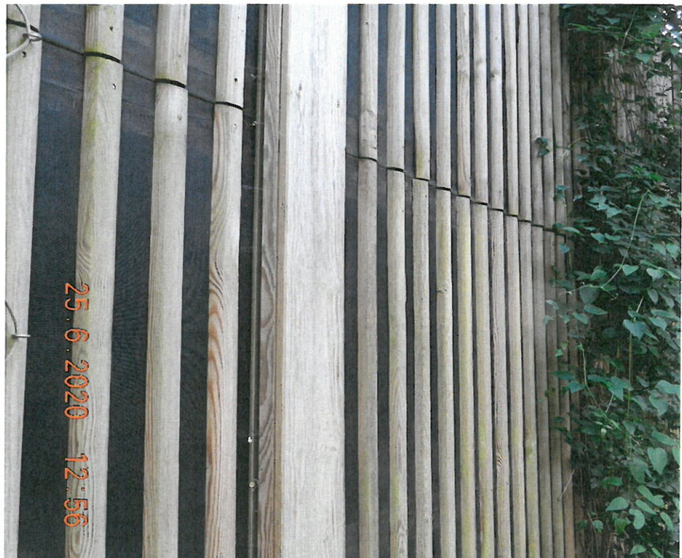
Ansicht Lärmschutzwand - Variante „Holzständerbauweise“
