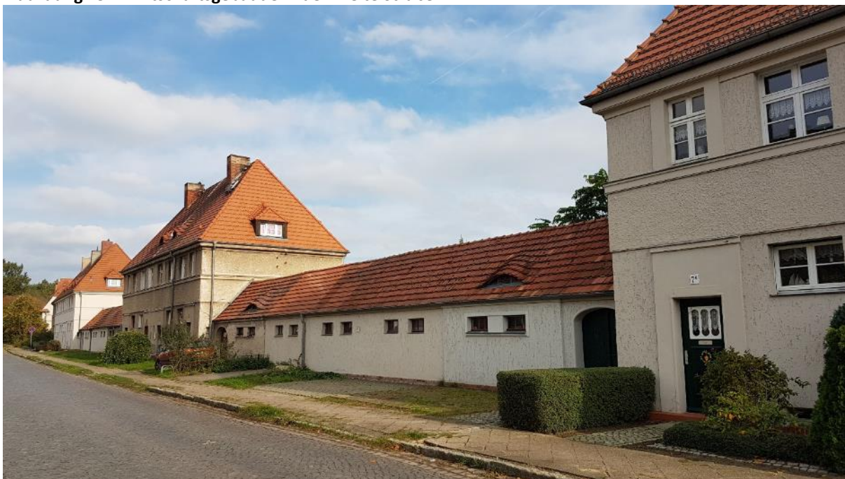
Abbildung 15: Wirtschaftsgebäude in der Breite Straße
