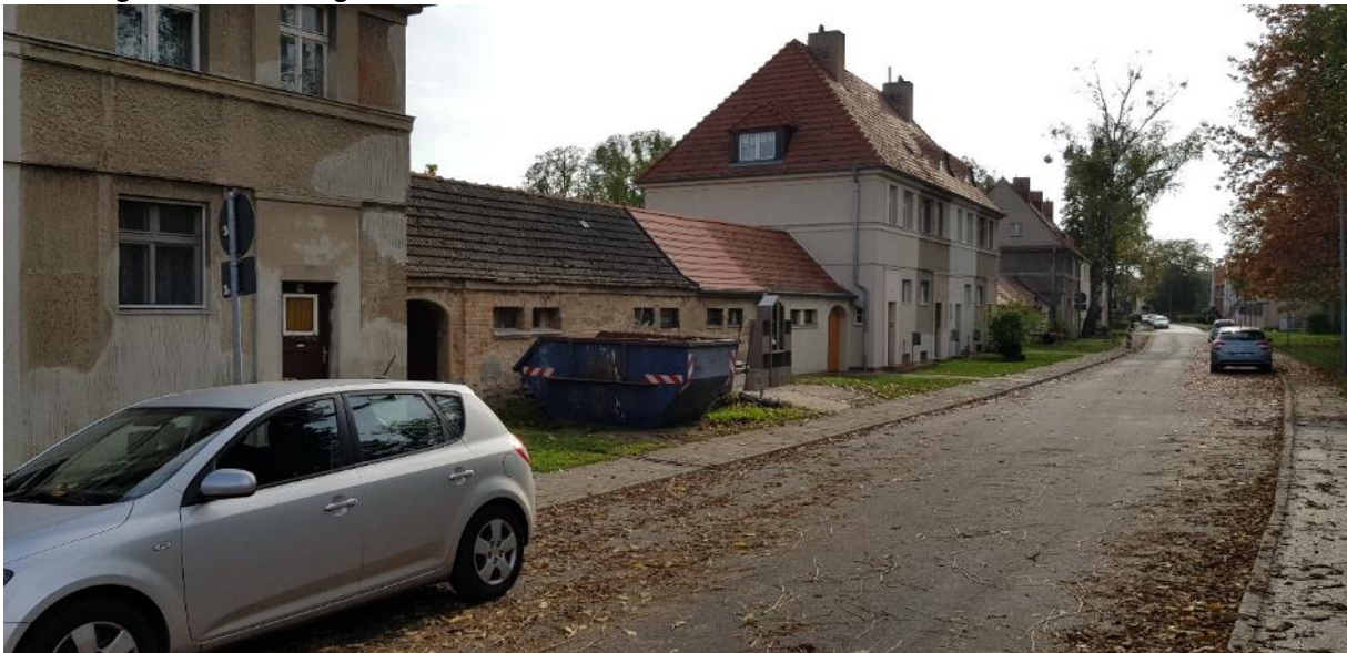
Abbildung 10: Wirtschaftsgebäude in der Gartenstraße
