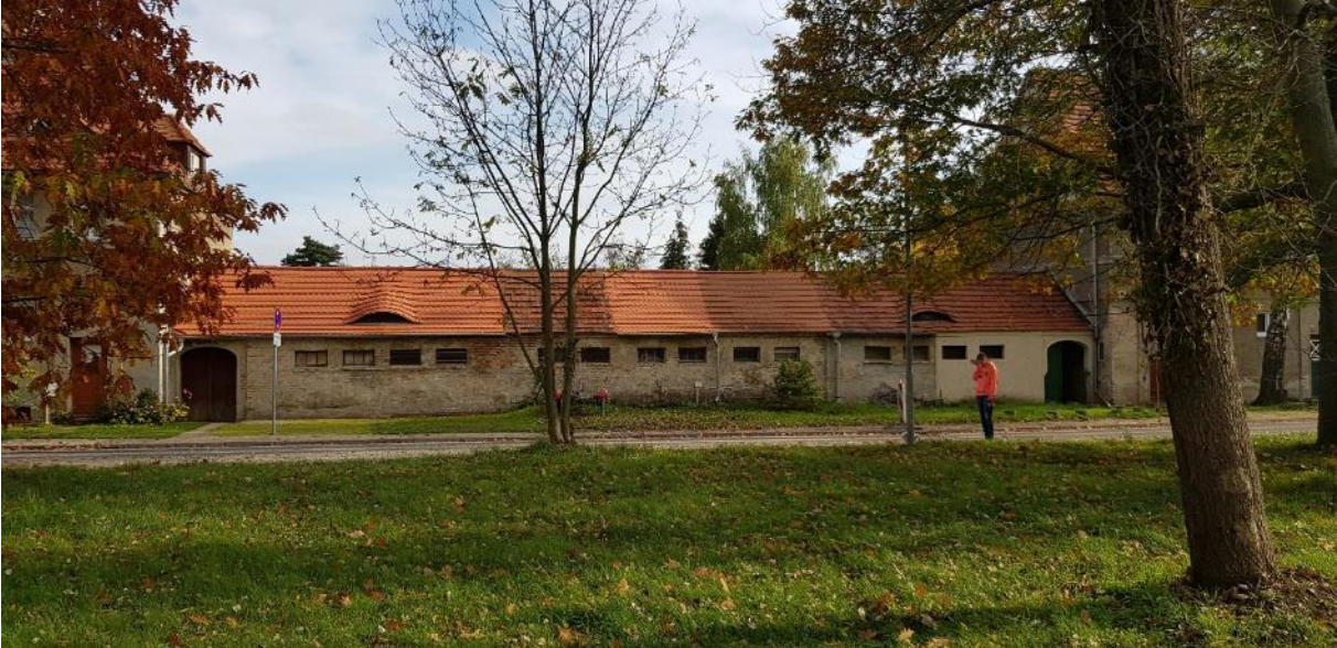
Abbildung 11: Wirtschaftsgebäude in der Gartenstraße
