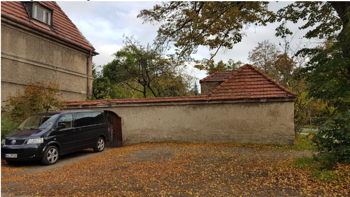
Abbildung 19: Wirtschaftsgebäude in der Breite Straße
