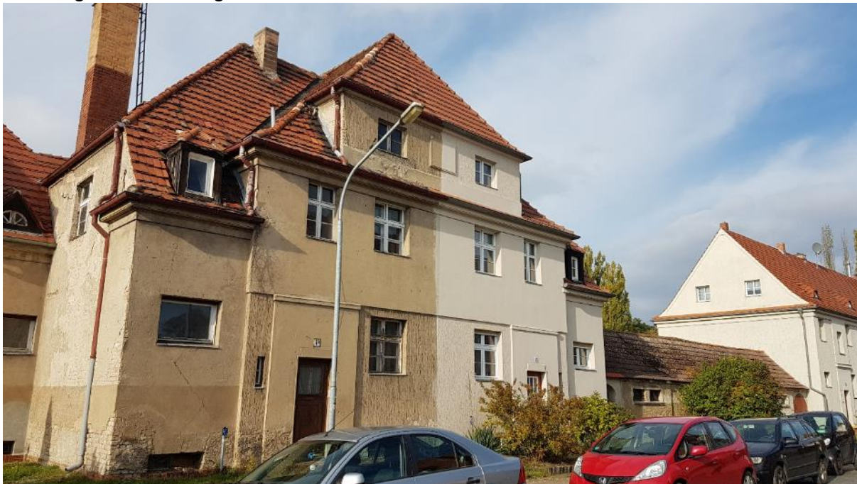
Abbildung 14: Wirtschaftsgebäude in der Breite Straße
