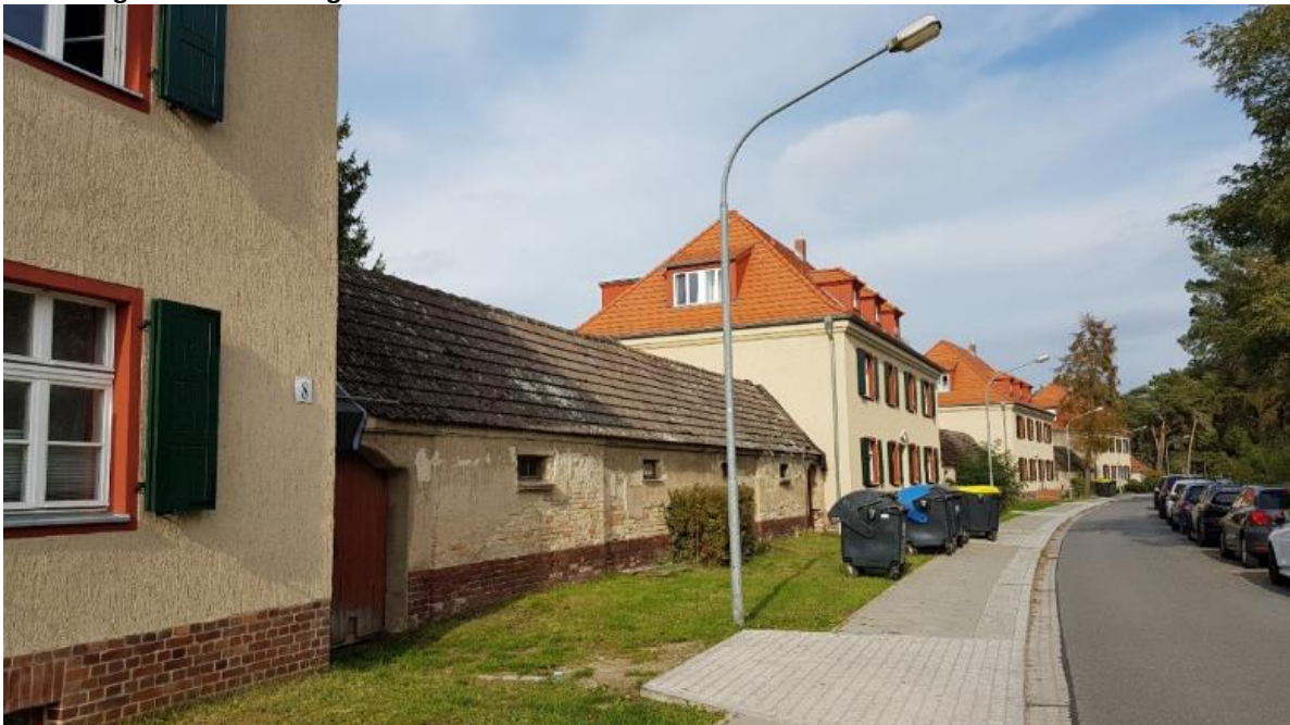
Abbildung 6: Wirtschaftsgebäude in der Schulstraße
