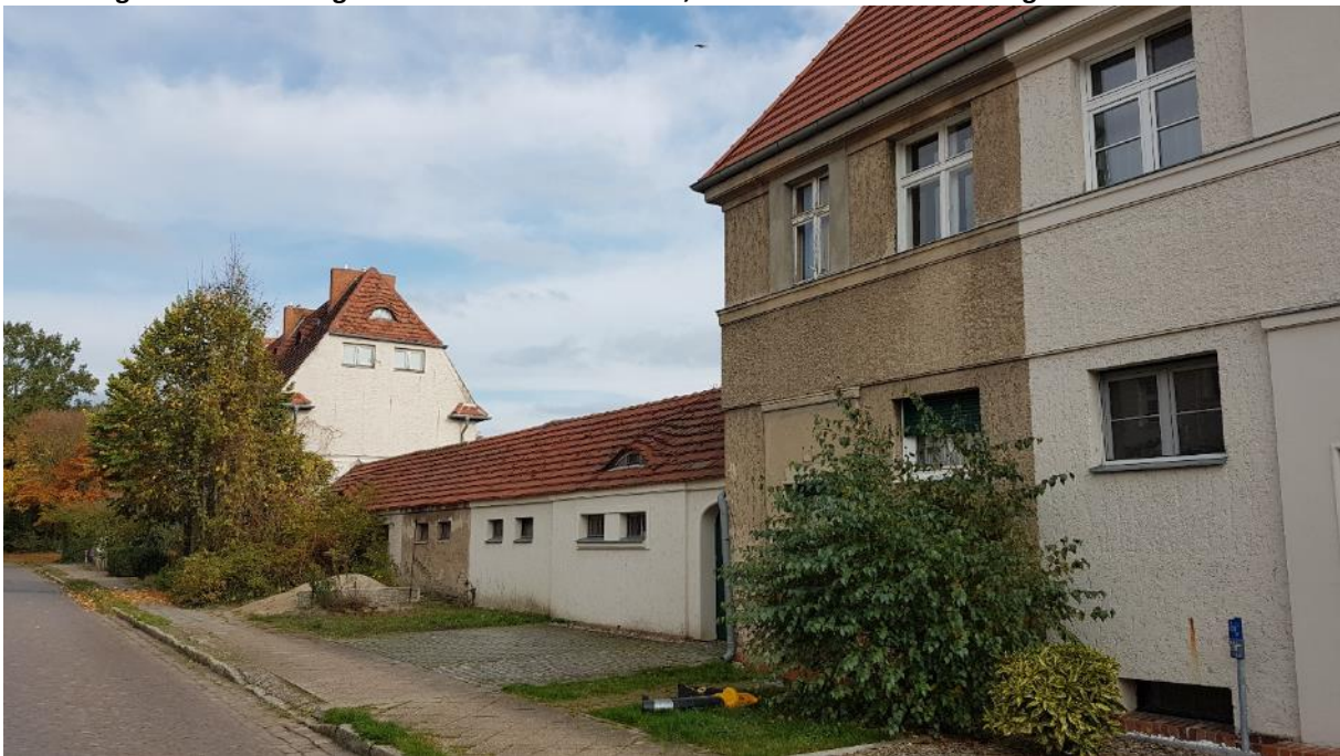
Abbildung 13: Wirtschaftsgebäude in der Breite Straße, unterschiedlicher Erhaltungszustand
