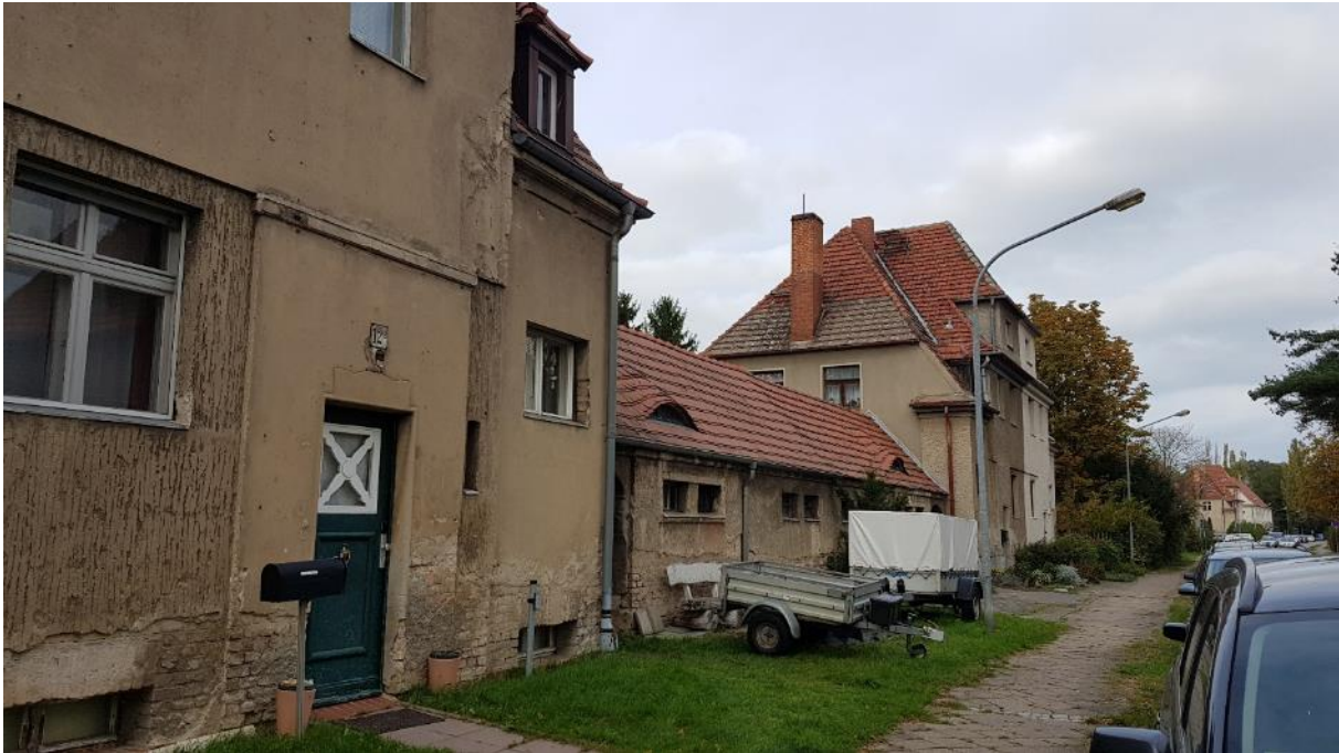
Abbildung 16: Wirtschaftsgebäude in der Breite Straße
