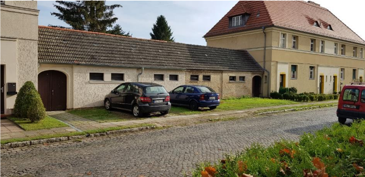
Abbildung 12: Wirtschaftsgebäude in der Gartenstraße
