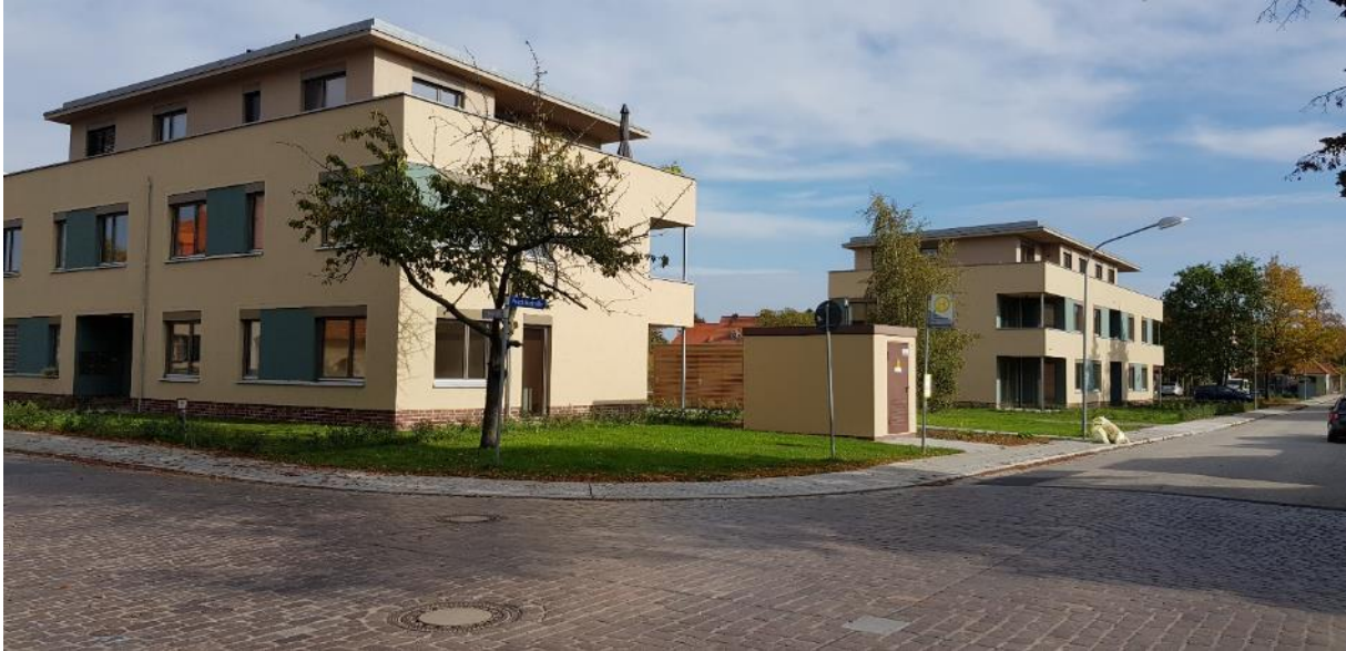
Abbildung 21: Neubauten in der Puschkinstraße und der Schulstraße
