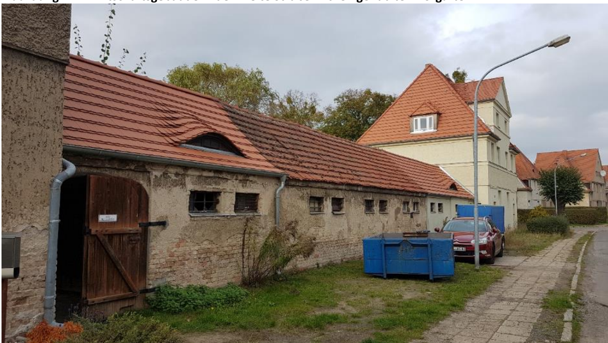
Abbildung 17: Wirtschaftsgebäude in der Breite Straße mit fehlgenutzten Vorgärten
