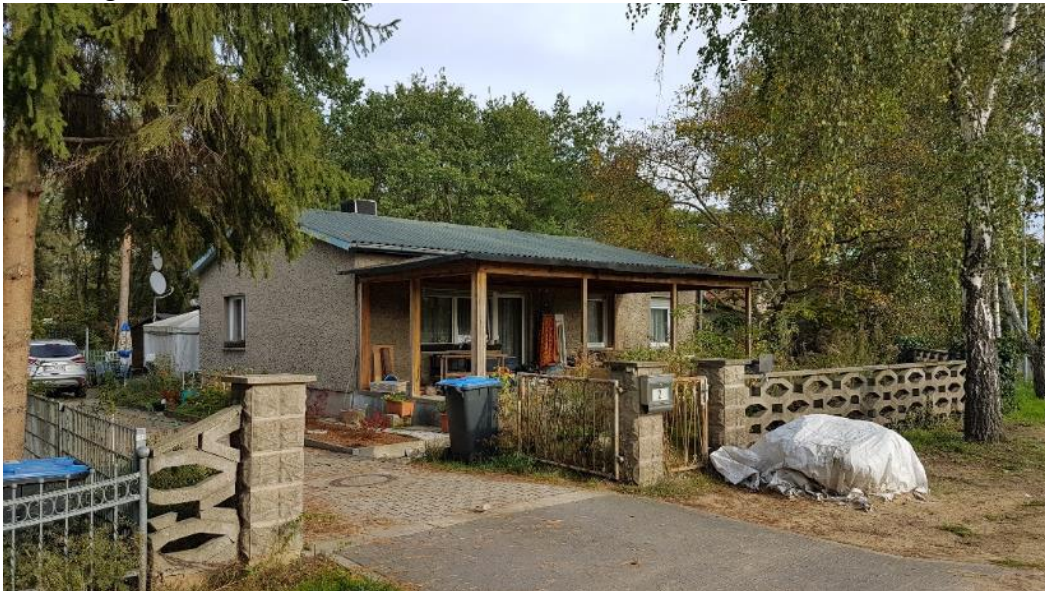
Abbildung 36: Wohnbebauung außerhalb der Eisenbahnersiedlung
