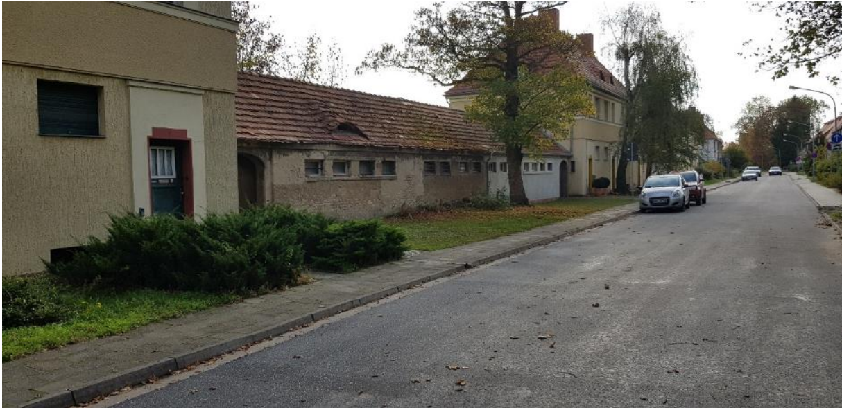
Abbildung 9: Wirtschaftsgebäude in der Gartenstraße
