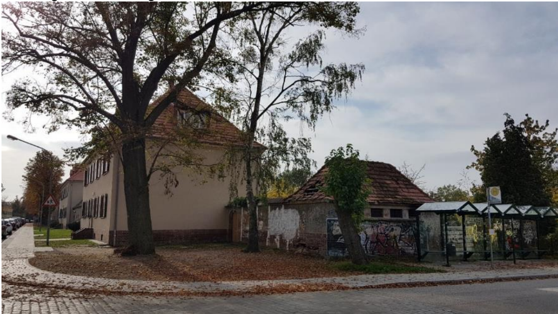
Abbildung 8: Wirtschaftsgebäude in der Schulstraße Ecke Puschkinstraße
