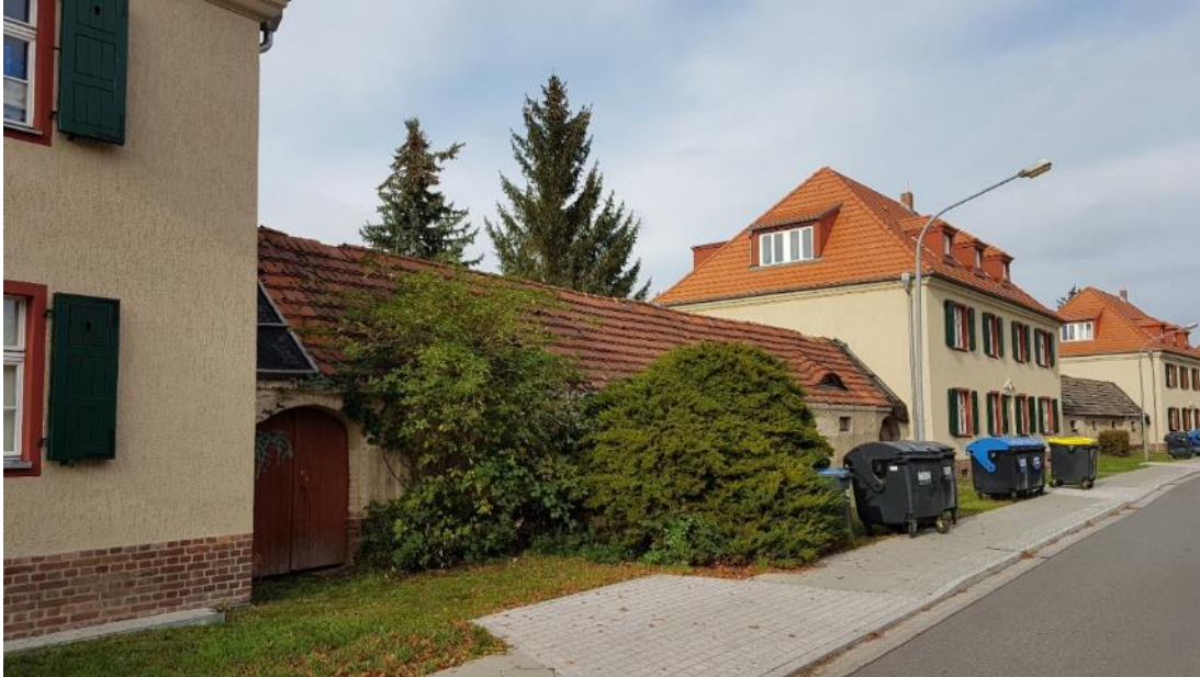
Abbildung 7: Wirtschaftsgebäude in der Schulstraße
