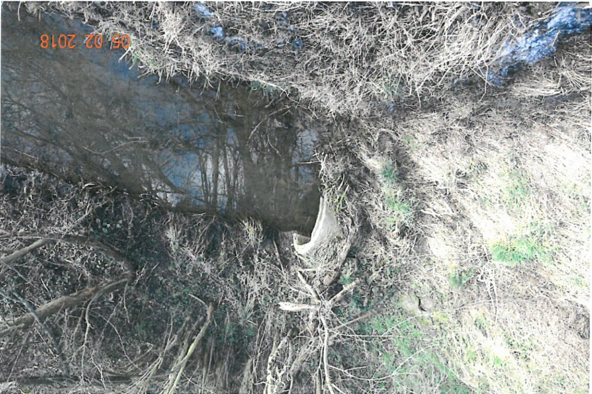
Bild 9: Messpunkt 2008 (s. Anlagen 5 und 6), Graben am Durchlass Südseite Brandenburger Straße
