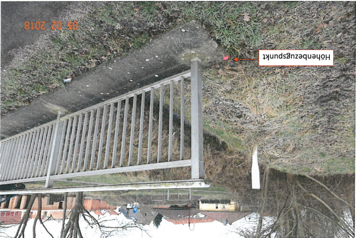
Bild 3: Messpunkt 1000 F (s. Anlagen 5 und 6), örtlicher Höhenbezugspunkt (Höhe = 100,000 m) (Südecke westlicher Sims am Durchlass L204)
