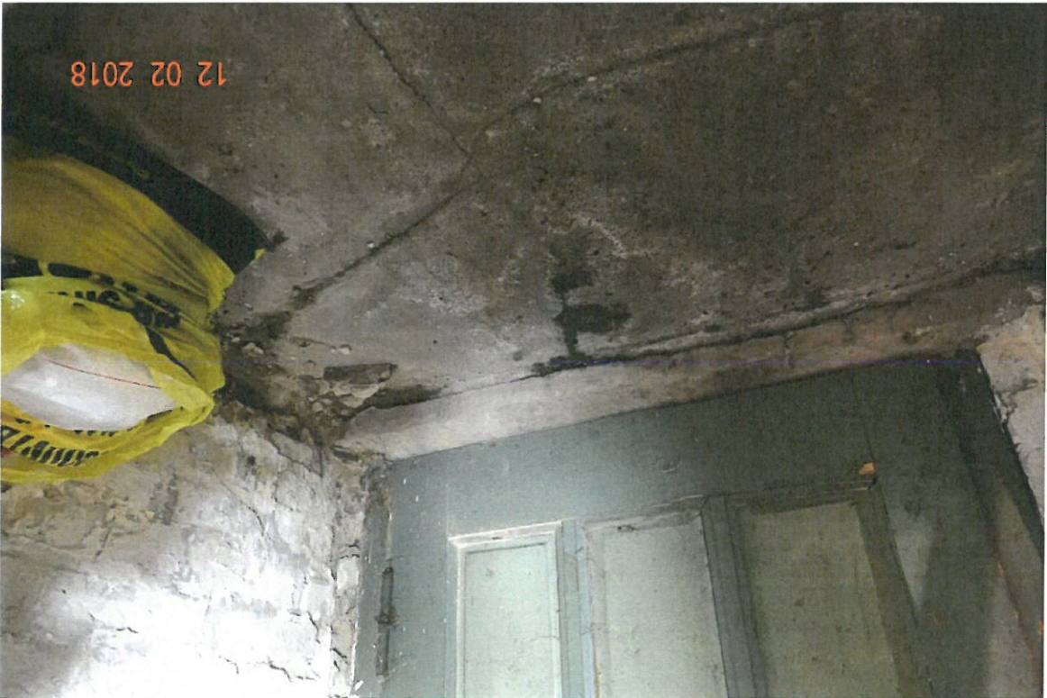
Bild 25: Wiesenstraße 15, Keller, nässende Risse im Kellerfußboden und Feuchteschäden an Wand
