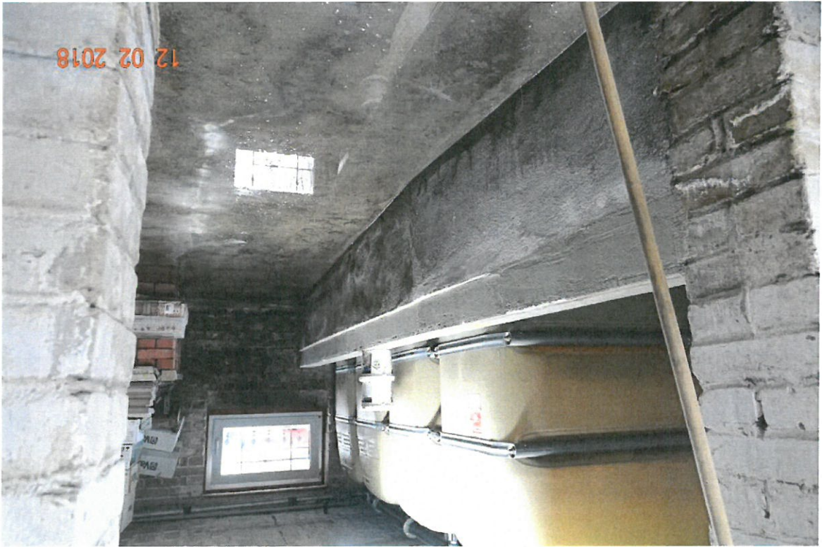
Bild 15: Wiesenstraße 7, Keller, Kellerraum mit Heizöltanks, vollflächig 1-2 cm unter Wasser
