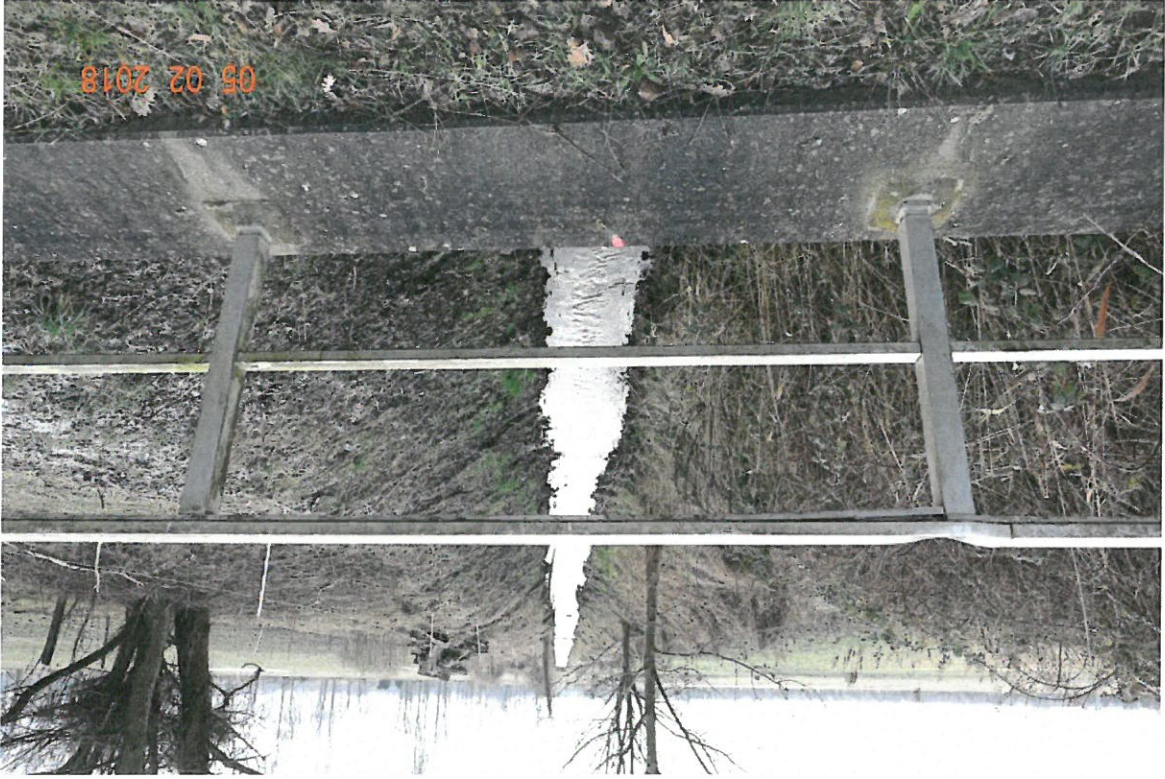
Bild 3: Messpunkt 1000 F (s. Anlagen 5 und 6), örtlicher Höhenbezugspunkt (Höhe = 100,000 m) (Südecke westlicher Sims am Durchlass L204)
