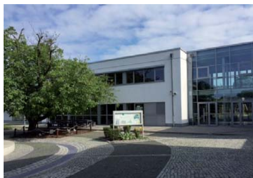
Erweiterungsanbau Oberschule, Blick vom Schulhof
