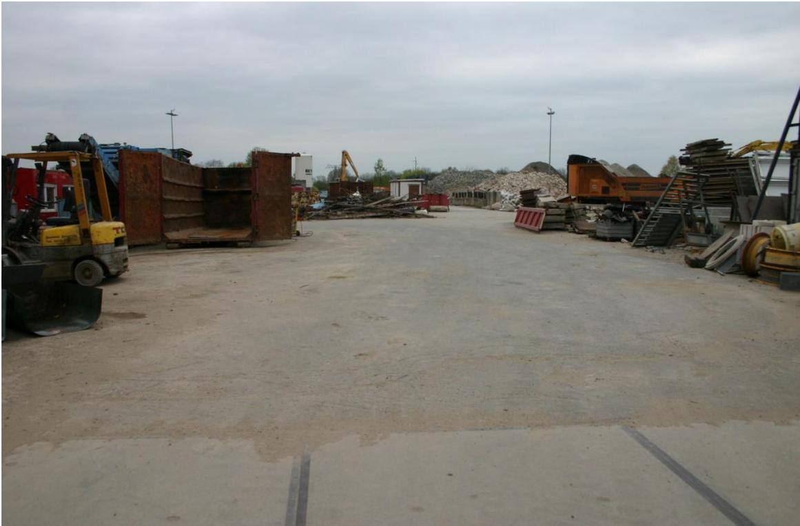
**Abbildung 23: Übergang von Bodenplatte (SB) zu Bituminösen Belag (BB), beides Vollversiegelung**
