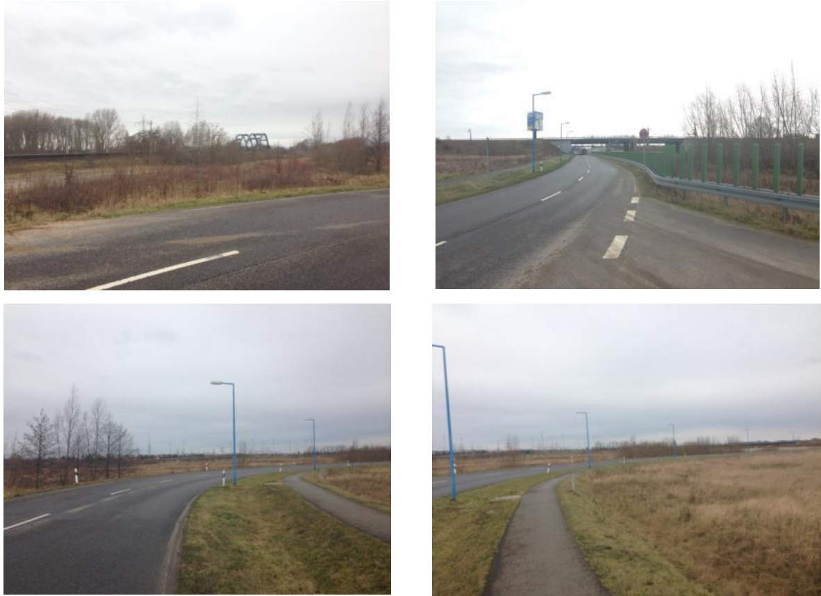
Abbildung 11 Photographische Bestandsaufnahme des Bebauungsplangebietes
