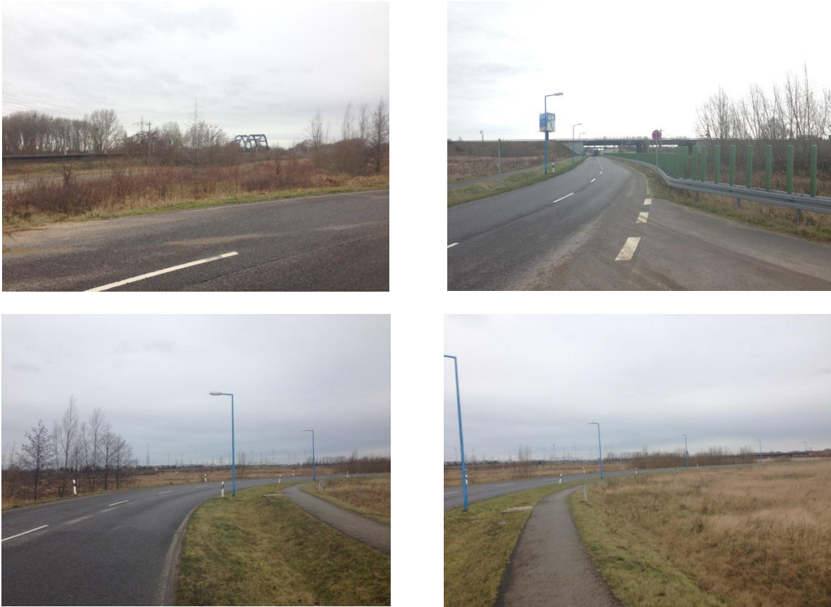
Abbildung 10 Photographische Bestandsaufnahme des Bebauungsplangebietes
