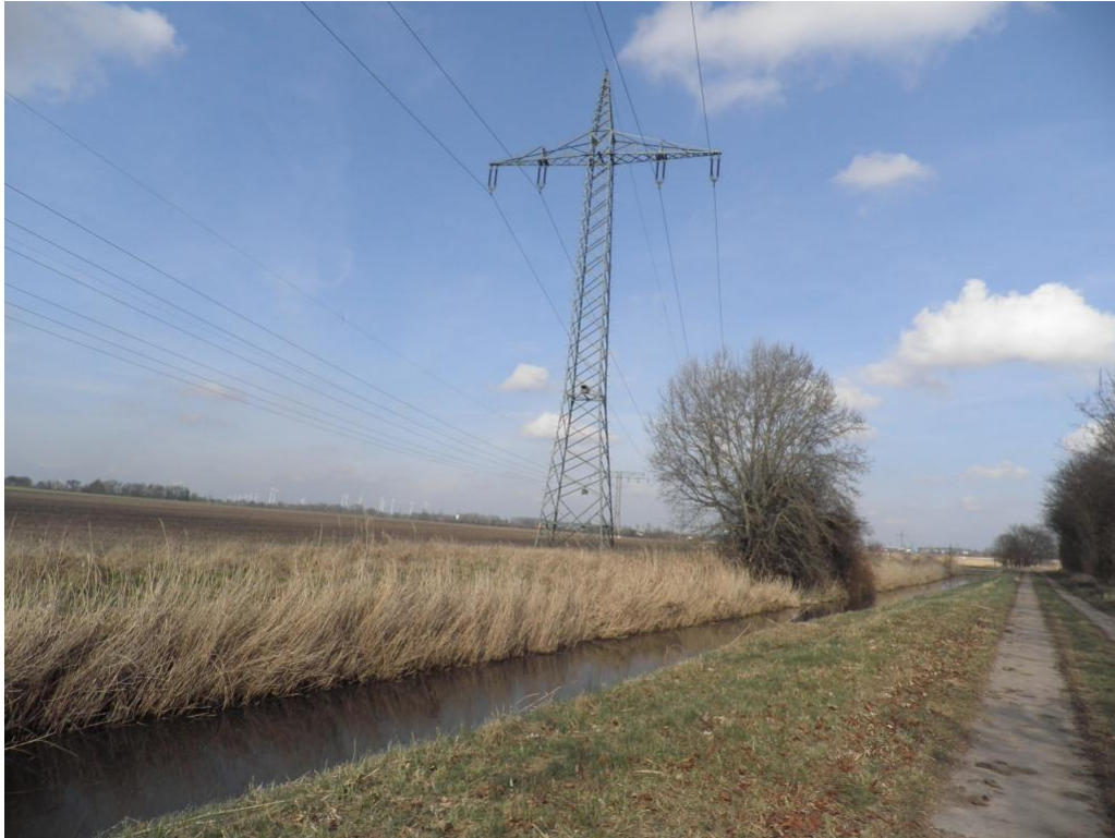
Bild 10: Blick auf 2 Hochspannungsfreileitungen, Graben und Betonplattenweg ca. 400 westlich des Änderungsbereichs
