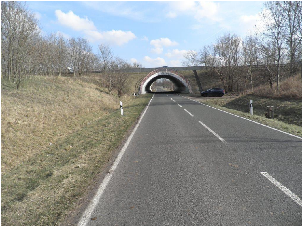
Bild 7: Blick vom west nach Ost auf K6305 mit Autobahntunnel A10 im Hintergrund
