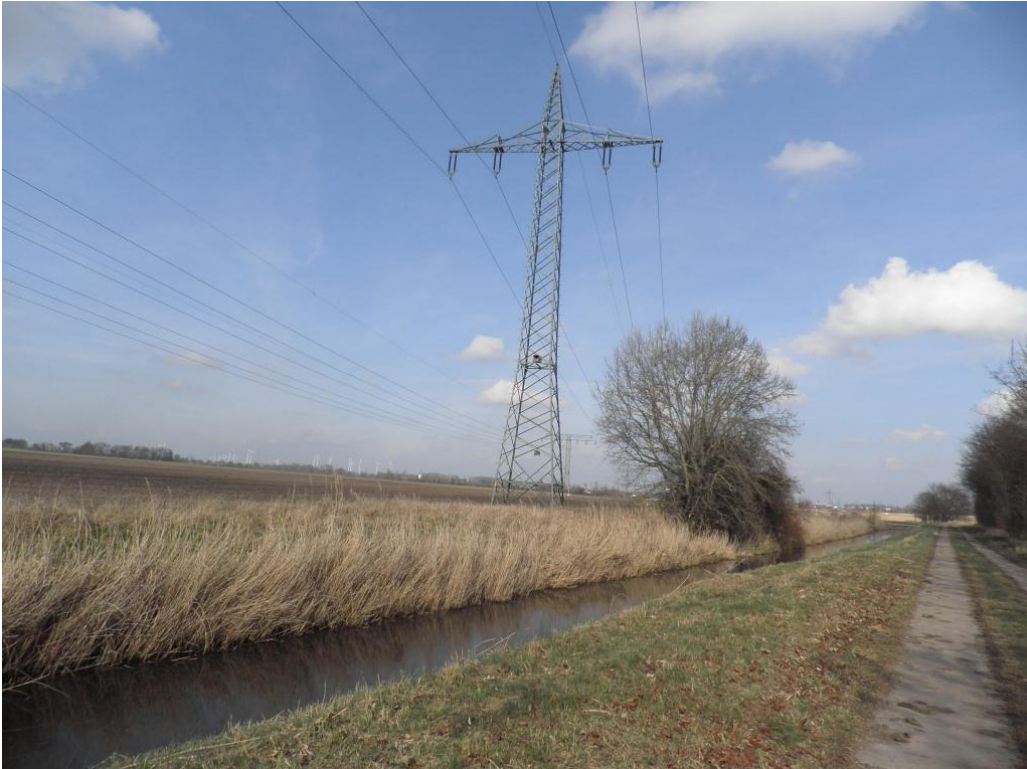
Bild 10: Blick auf 2 Hochspannungsfreileitungen, Graben und Betonplattenweg ca. 400 westlich des Plangebiets.
