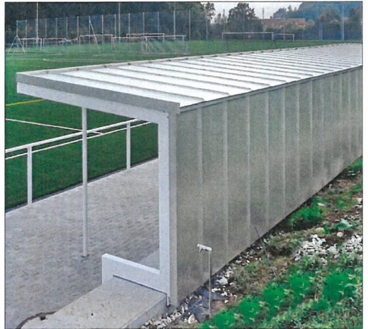
Unterstand, Material: Beton, Stahl und Blechverkleidung
