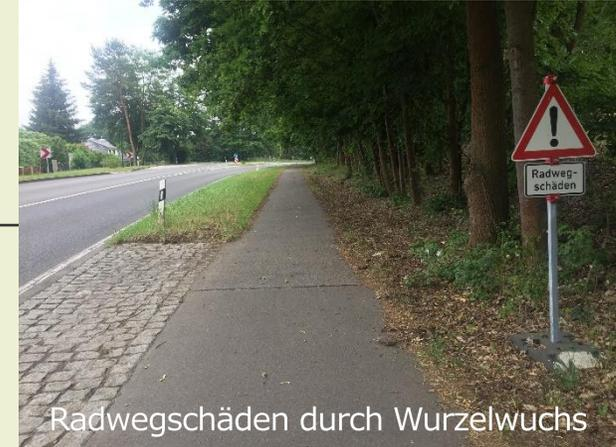
Radwegschäden durch Wurzelwuchs
